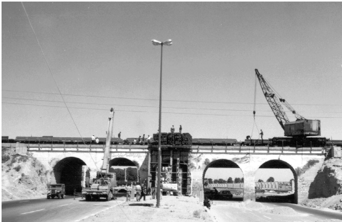
شکل ۱: بارگذاری پل قوسی بتنی اکبرآباد در آزمایش استاتیک.
