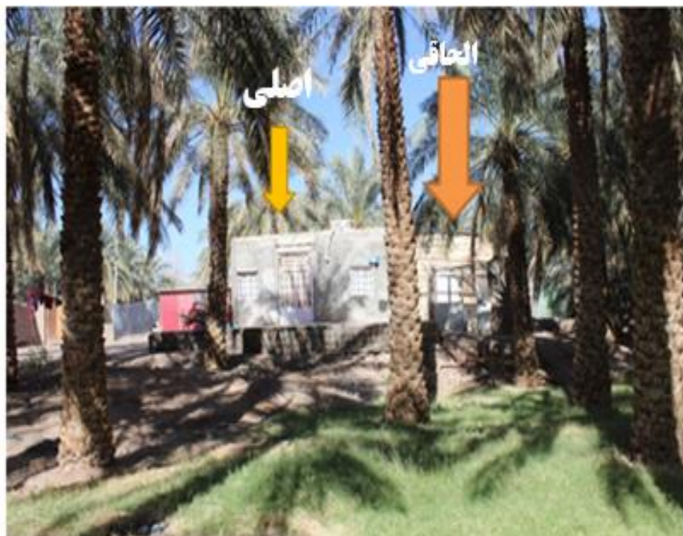
شکل ۳. الحاق و ساخت فضاهای مورد نیاز غیر اصولی به ساختمان طرح بازسازی، سکونتگاه روستایی سروند بم
