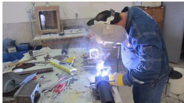
شکل ۱۱ عمليات نصب لوله جهت تنش گيرى اولتراسونيك
