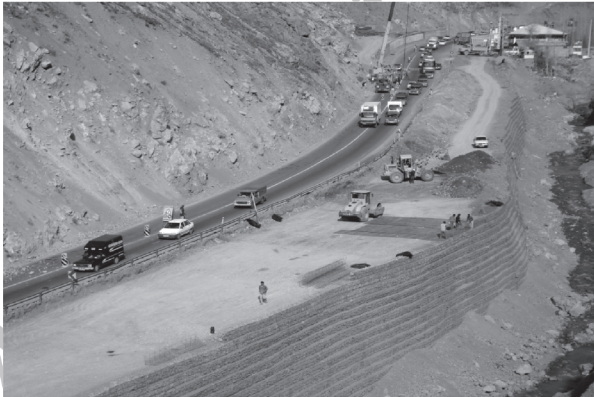
شکل ۳: اجرای دیوار حائل ژئوگریدی برای تعریض محور
