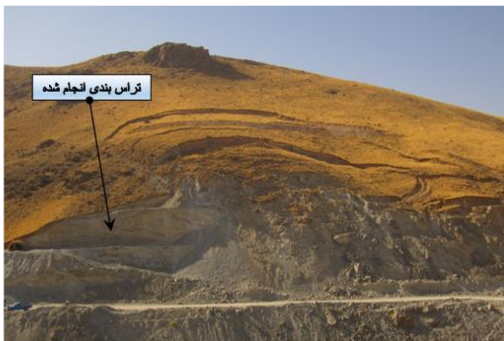
شکل ۲. وضعیت لغزش در شیروانی
