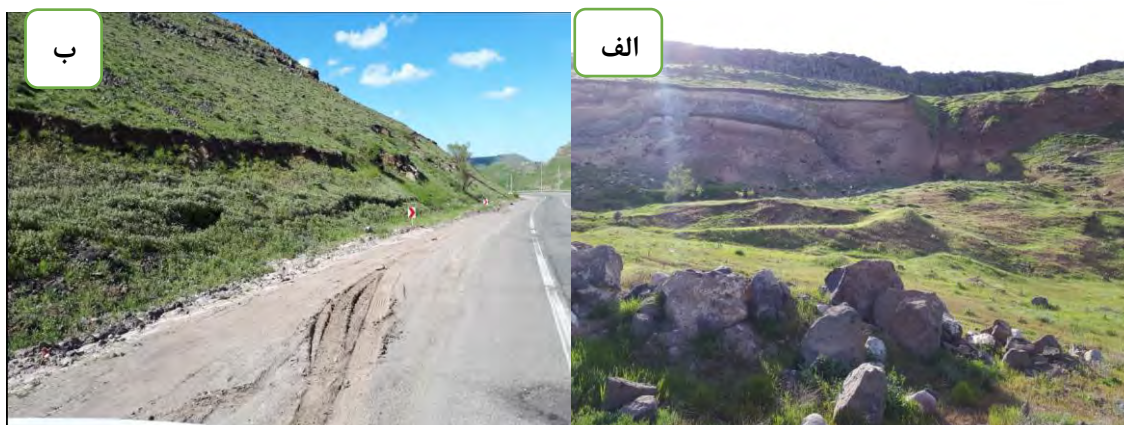
شکل ۶. الف: گسیختگی ایجادشده در دامنه همراه با انتقال مواد به سمت پایین دامنه؛ ب: ایجاد ترانشه در دامنه با شیب بسیار تند مستعد حرکات دامنه‌ای
