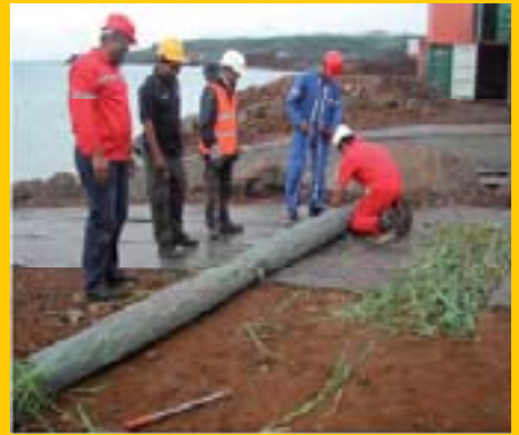
استفاده از گیاهان موجود در منطقه که در داخل تورهای مشبک فلزی قرار می‌گیرند
