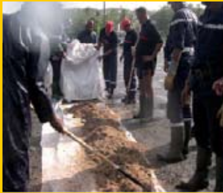
استفاده از باگاس که در داخل پوشش‌های پلی پروپیلن قرار می‌گیرد
