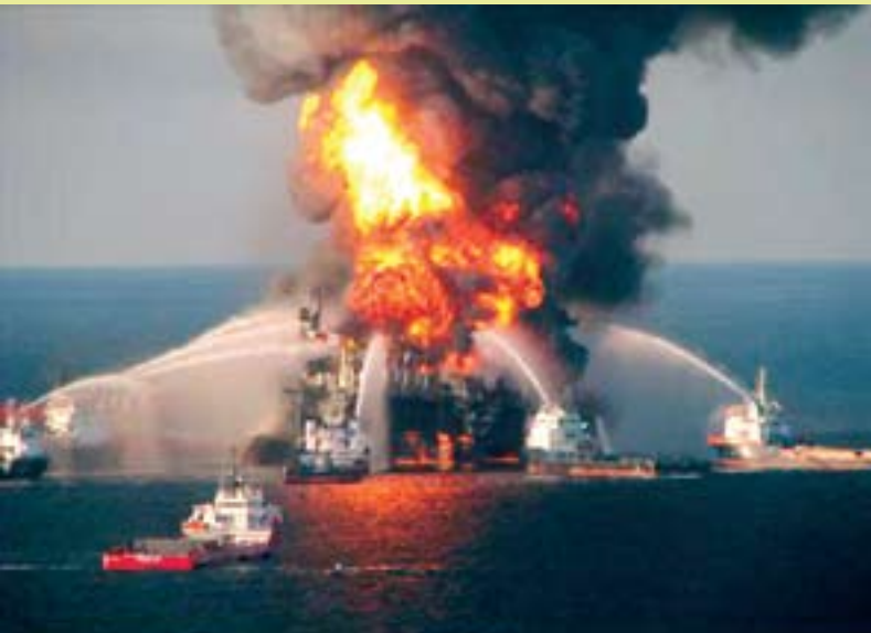
شکل ۷- حادثه سکوی هوریزون در خلیج مکزیک، برخی علت اصلی این رخداد را هیدرات تشکیل شده در شیر فوران‌گیر می‌دانند.
