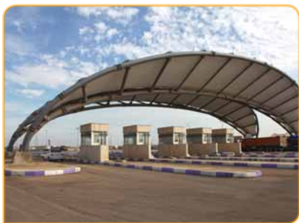
احداث معابر و جاده‌های دسترسی
