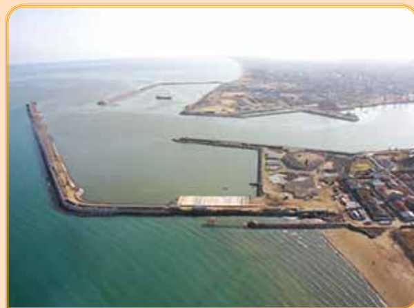
احداث دایک‌ها و موج‌شکن‌های شرقی و غربی
