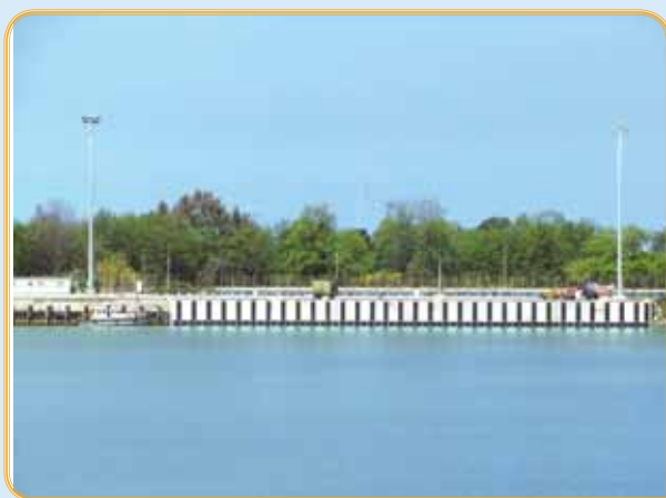
احداث اسکله خدماتی بندر نوشهر به طول ۸۶ متر جهت پهلوگیری شناورهای خدماتی
