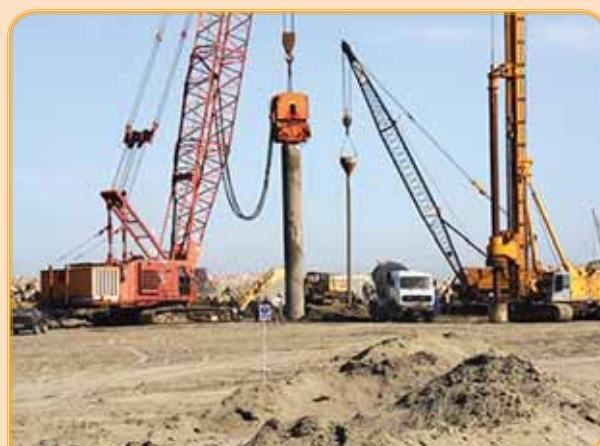
شروع و ساخت اسکله‌های جدید
