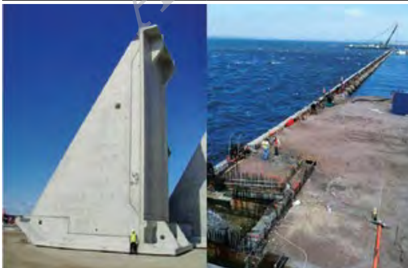
شکل ۶- نمای دیوارهای پشت‌بنددار
