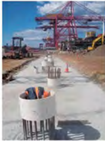
شکل ۷- جانمایی شمع های زیر تیر جرثقیل سمت خشکی
