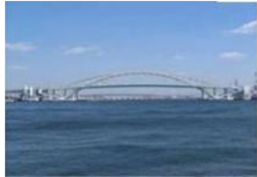
شکل ۶- پل شناور در اوزاکای ژاپن
