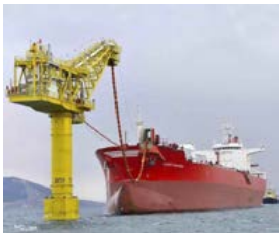
شکل ۲: ترمینال شناور Fixed Tower Single Point Mooring (FTSPM)
