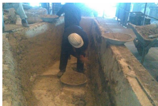
شکل ۲: ایستگاه پلاسترنی تاندیش - قبل از مداخله
