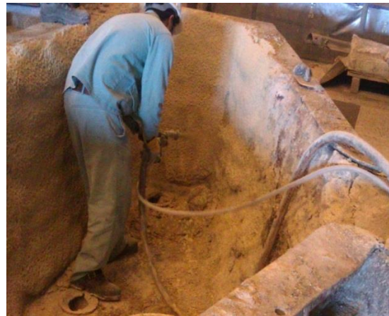
شکل ۴: ایستگاه کاری پلاسترزنی - بعد از مداخله
