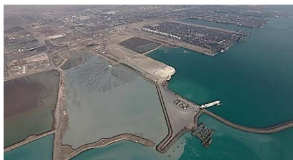
شکل (۲): عکس هوایی از دایک‌های حفاظتی احداث شده در فاز توسعه بندر شهیدرجایی
