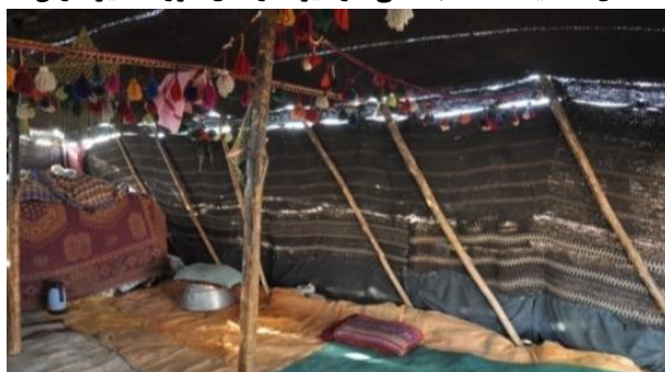
شکل ۲- قرارگیری دیرک‌های مایل.، نویسنده
