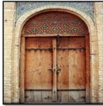
شکل ۱۰- دیوارهای قطور آجری و درب چوبی
