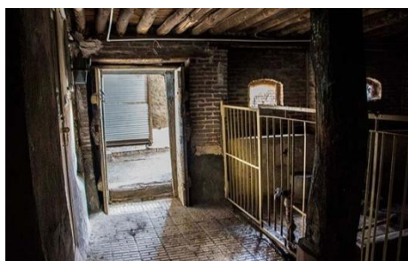
شکل ۱۳ نمای داخلی طبقه همکف مسجد قوله
