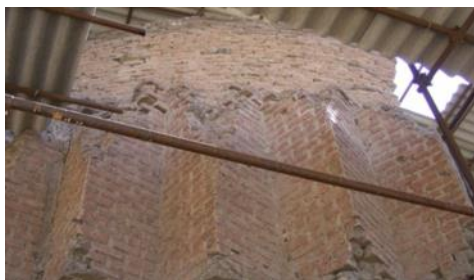
شکل ۱۱: آجرچینی افقی محل اتصال گنبد به ساقه‌ی ترک‌های منشوری، (منبع: نگارندگان، ۱۳۹۶)
