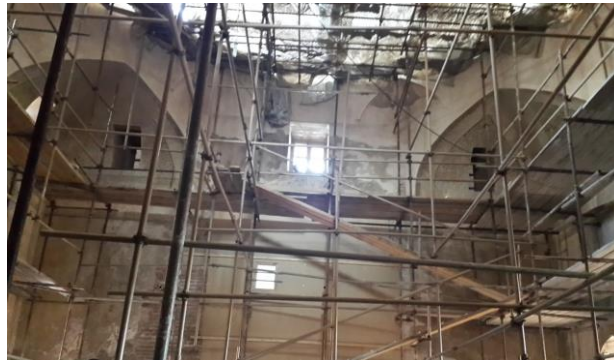
شکل ۴- منطقه انتقال چهار ضلعی به هشت ضلعی، (منبع: نگارندگان، ۱۳۹۶)
