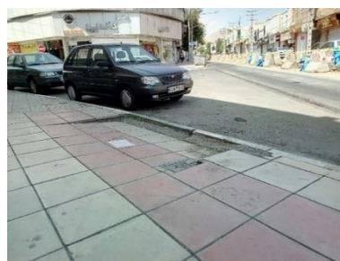
تصویر ۳ - علاوه بر منتهی شدن رامپ به جدول، در تقاطع خیابان از هیچگونه خط‌کشی استفاده نشده است.
