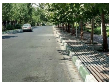
تصویر ۱۲- کفسازی نامناسب و عدم وجود ارتباط مناسب با ضوابط معلولین در ارتباط با خیابان
