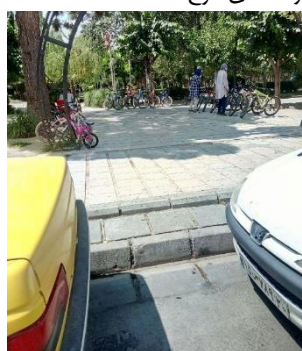
تصویر ۹- تعبیه نشدن رامپ در هیچ یک از قسمت‌های ورودی جهت ورود معلولین به داخل پارک
