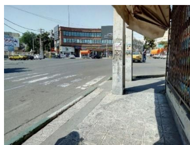
تصویر ۵ - کفسازی بسیار نامناسب
