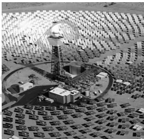
شکل ۱- نمایی از نیروگاه برج خورشیدی
