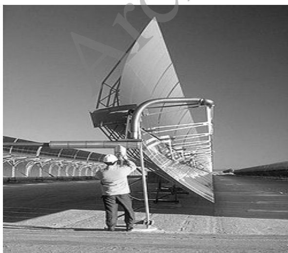
شکل ۳- مقیاس صنعتی آینه‌های سهموی خطی
