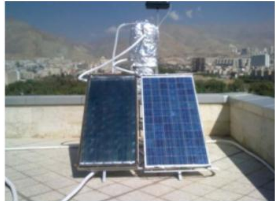
شکل ۱- تصاویری از آبگرمکن خورشیدی فتوولتائیک/ حرارتی
