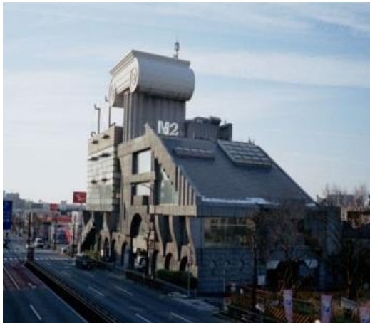
تصویر ۲- ساختمان M2-توکيو- ژاپن. www.kkaa.co.jp
