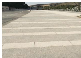
کفسازی مناسب پیاده راه
