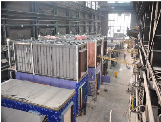
تصویر ۵: ساخت واحدهای برج کارمل پلیس در کارگاه منبع: (Mears&Ruth.2019)
