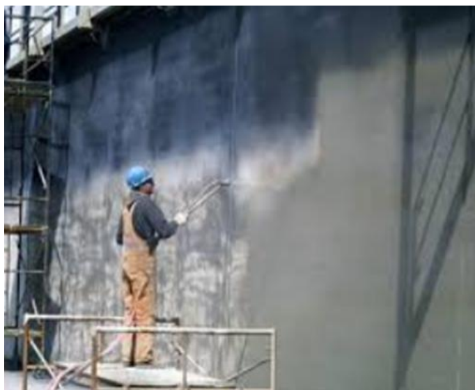
شکل ۲- پوشش نفوذگر کریستال شونده Aquafin IC (منبع: www.clinicetcon.com)
