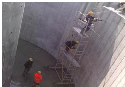
شکل ۳- تزریق رزین اپوکسی در بدنه سد ها (www.clinicbeton.com)
