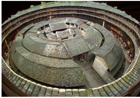
تصویر ۷- خانه چنگ چی در منطقه یونگ دینگ در ایالت فوجیان، چین. حلقه های سه گانه در اطراف ساختمان مرکزی وجود دارد. (مأخذ: Knapp, Ronald G, 1989)
