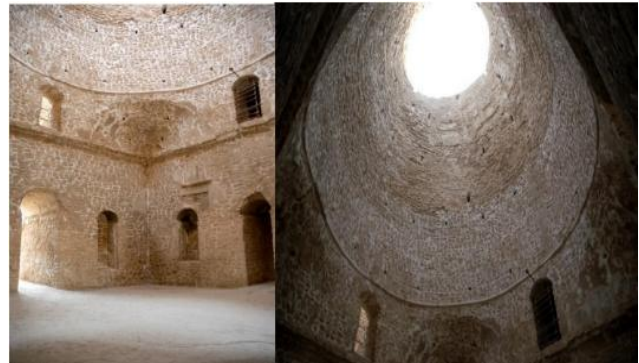
شکل ۵- گنبد کاخ؛ دید از نمای داخلی، کاخ فیروزآباد و استفاده از فیلیوش برای انتقال از سطح مربع به دایره (مأخذ: کیانی و فیروزمندی شیره جینی، ۱۳۹۸: ۱۵۴)
