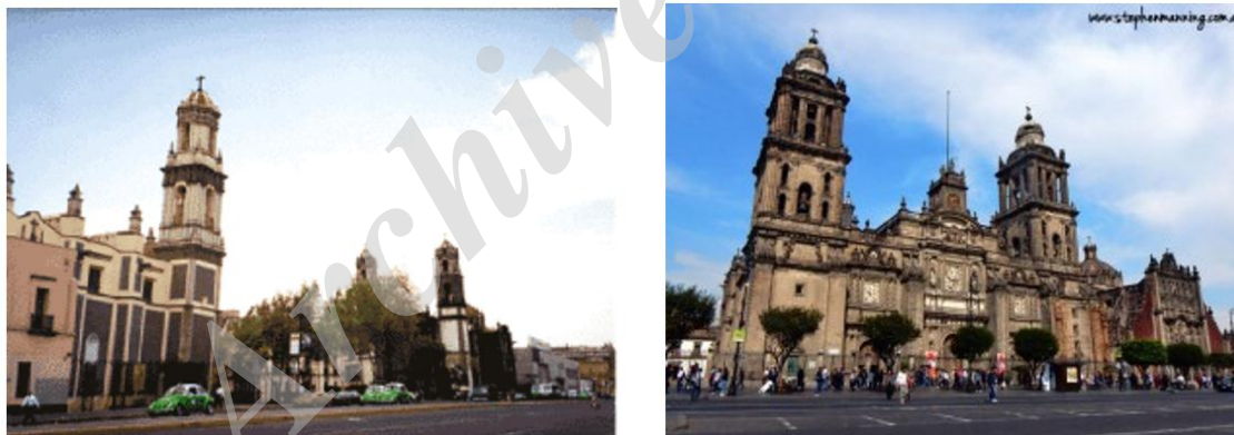
شکل ۷: فرو رفتن سازه های تاریخی شهر مکزیکوسیتی در اثر نشست لایه های رسی اشباع [۹]
