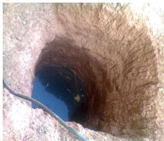
شکل ۱۲: (الف) سطح آب زیرزمینی بالا در چاه دستی حفاری شده (ب) خاک حاصل از خاکبرداری چاه دستی
