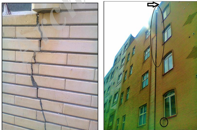
شکل ۴: نمونه ای از بروز نشست سازه ها کوی باغمیشه
