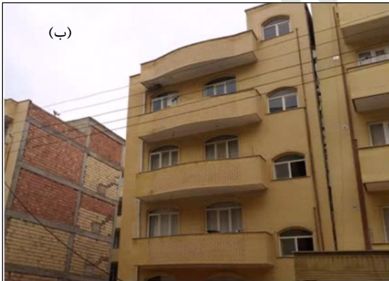
شکل ۶- نمونه‌ای از سازه‌های آسیب دیده با پی سطحی در شهر تبریز: (الف) سازه کج شده در کوی فرشته و تصویری از ترک‌های نمای ساختمان [۲۳]، (ب) سازه کج شده در کوی شرکت گاز [۱۱].
