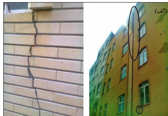
شکل ۶- نمونه‌ای از سازه‌های آسیب دیده با پی سطحی در شهر تبریز: (الف) سازه کج شده در کوی فرشته و تصویری از ترک‌های نمای ساختمان [۲۳]، (ب) سازه کج شده در کوی شرکت گاز [۱۱].
