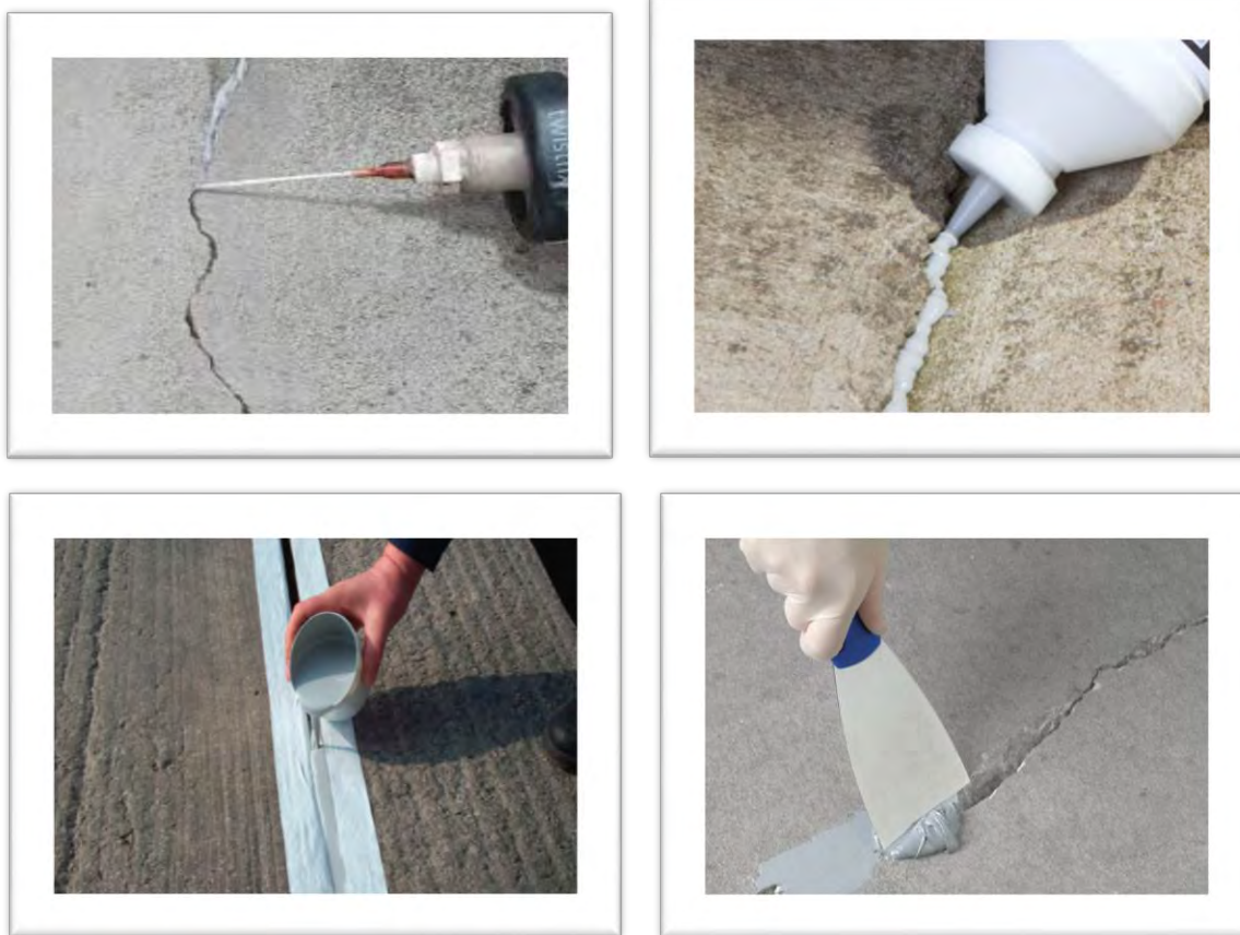
شکل ۳: پر کردن مستقیم دهانه شکاف با مواد ترمیمی و اپوکسی.
