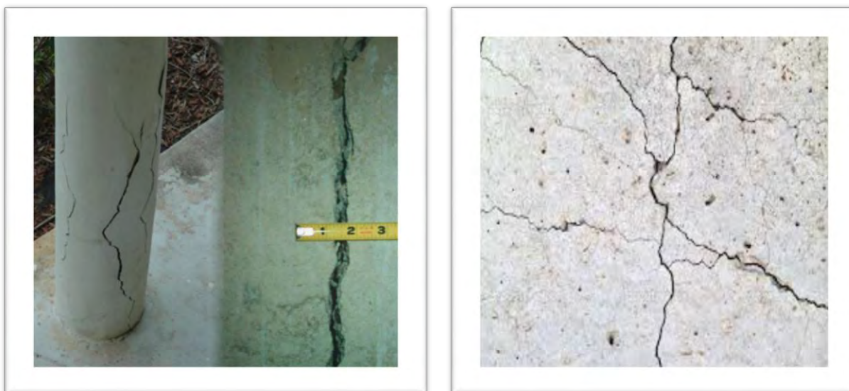
شکل ۱: شکل های مختلف ترک و اندازه گیری دهانه ترک.
