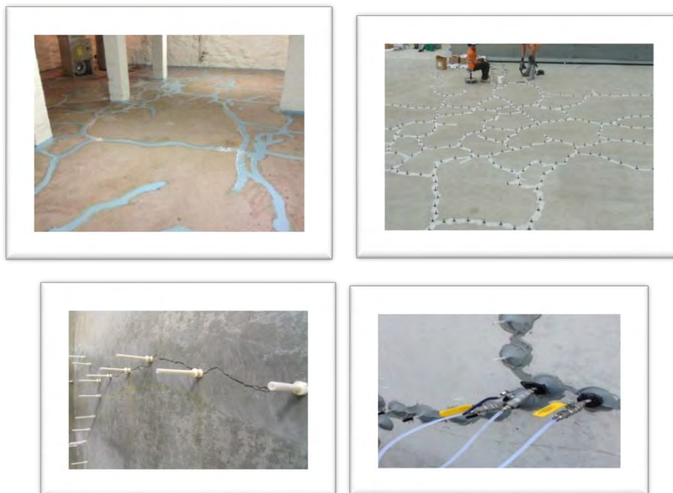
شکل ۱۰: نمونه ای از سطوح بتنی در حال تعمیر یا تعمیر شده.
