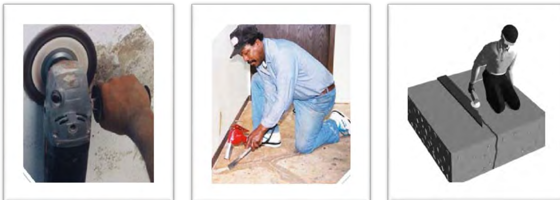
شکل ۸: برداشتن لایه درپوش با حرارت و کندن و پرداخت نهایی.
