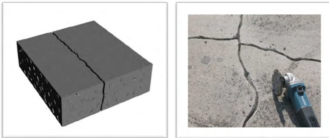
شکل ۲: ایجاد شیار روی ترک ها جهت دسترسی بهتر و پاک کردن داخل شیار از کلیه ضایعات با فشار هوا یا آب.
