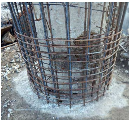
شکل ۲۳: کاشت میلگرد در پایه پل مدل آزمایشگاهی.
