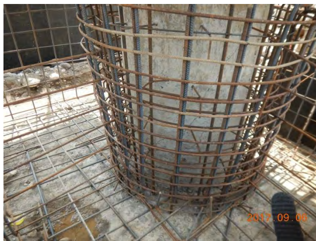
شکل ۲۴: آرماتوربندی ژاکت بتنی پایه پل مدل آزمایشگاهی.
