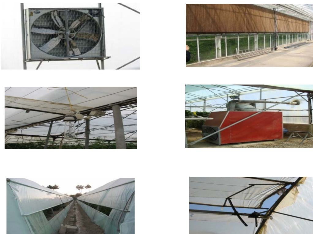
شکل ۳- شمایی از وسیله‌های گلخانه‌ای کنترل‌کننده شرایط محیطی درون گلخانه: الف- سرمایش پوشال و پنکه، ب- سرمایش پوشال و پنکه، پ- سامانه گرمایش، ت- سامانه روشنایی تکمیلی، ث- دریچه تهویه سقفی، ج- پنجره‌های تهویه کناری.
