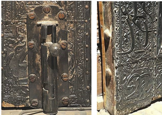
تصویر شماره (۲۰) ضخامت و محل نصب پاشنه گردهای درب تصویر شماره (۲۱) چفت کشویی نصب شده در پایین درب
