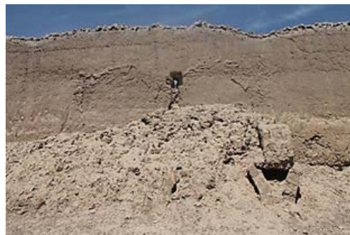
تصویر ۵. بقایای اتاق‌های دو طبقه قلعه در ضلع شمال غربی. در تصویر نقطه شروع تاق بر روی دیوارها در طبقه دوم قابل مشاهده است (نگارندگان).
