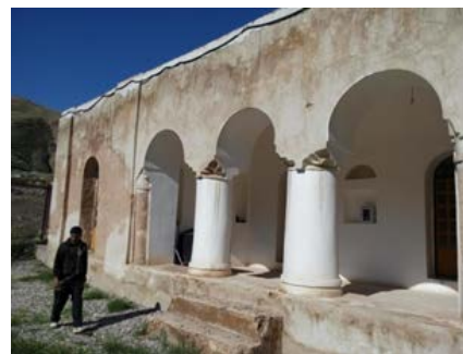
تصاویر ۹. نمایی از ستون‌های درگاه جنوبی و طاق ضربی قلعه جهانگیرآباد (نگارنده).
