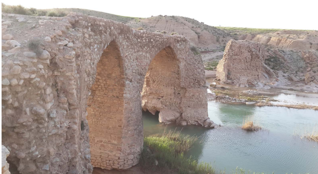
تصویر ۱۳. نمای پل از سمت جنوب شرقی (نگارندگان، ۱۳۹۶).
