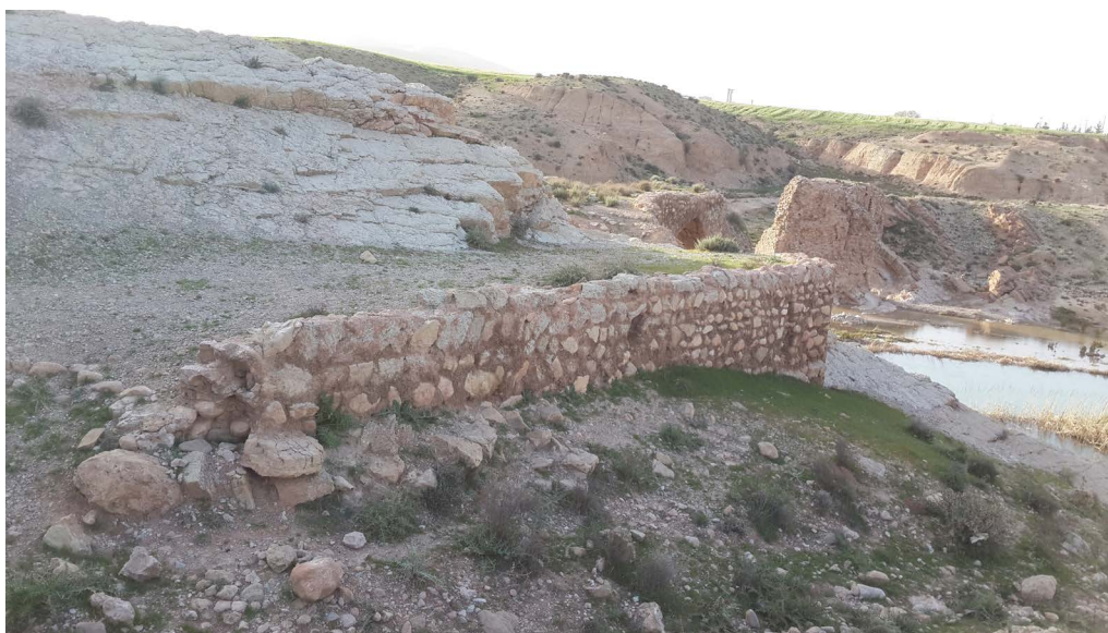
تصویر ۱۶. صفا در سمت جنوب پل که بالاجبار به جهت دور زدن صخره ساخته شده است (نگارندگان، ۱۳۹۶).
