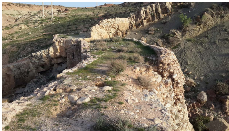
تصویر ۱۵. به علت قرارگیری صخره در سمت جنوب بالاجبار مسیر پل منحرف شده است (نگارندگان، ۱۳۹۶).
