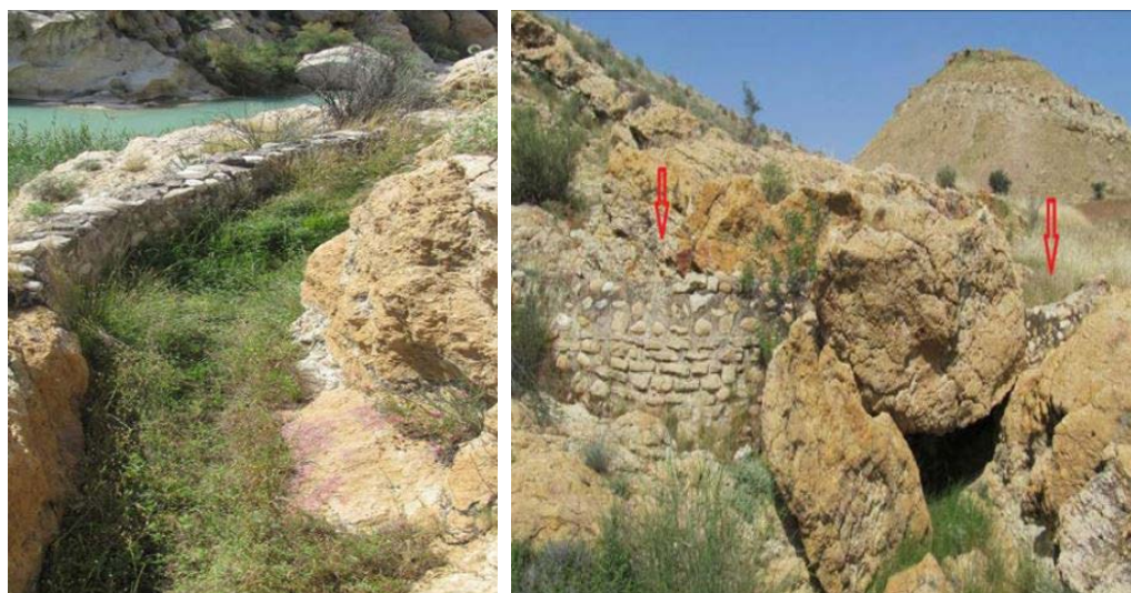
تصویر ۷. دیواره سنگ و ساروجی جهت هدایت آب از بند به قنات گرمز (رایگانی، ۱۳۹۴: ۲۰۱)؛ کانال انتقال آب از بند به قنات گرمز در ارجان (همان: ۲۰۲).
