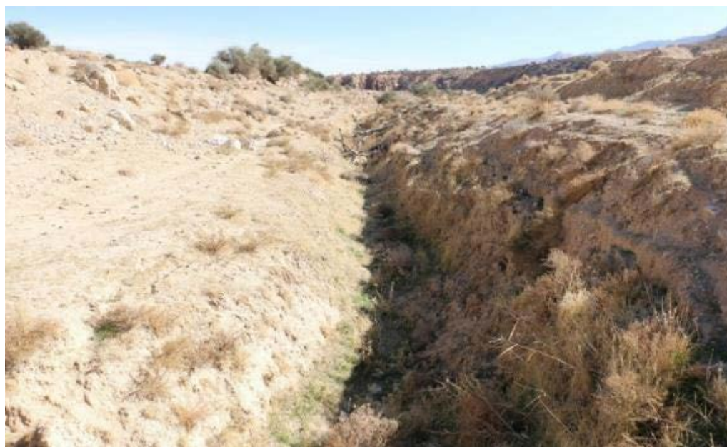
تصویر ۶. انتهای قنات (مظهر) و ابتدای کانال روبازی که به وسیله آن آب به خفر می‌رسیده است (نگارندگان، ۱۳۹۶).
