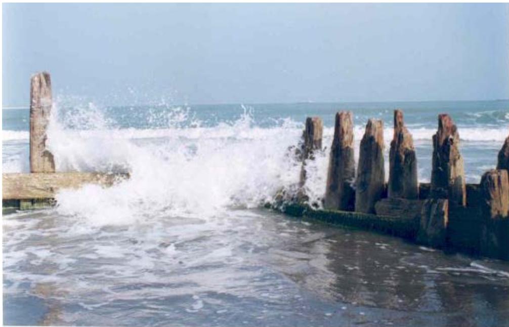
تصویر ۹. تخریب شدید کشتی نکا به وسیله امواج دریا (سورتیجی، ۱۳۸۲).
