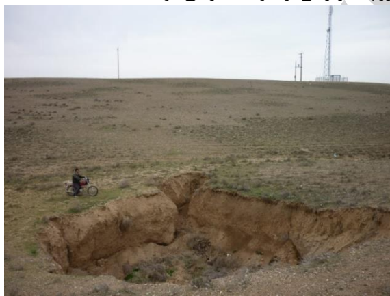
شکل ۶- فروچاله‌های ریزشی تشکیل شده در مجاورت رودخانه Fig. 6 Falling holes formed in the vicinity of the river
