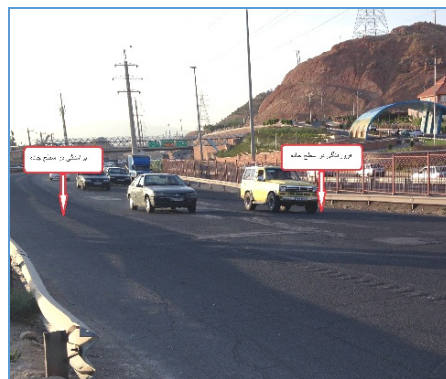
شکل ۱. تصاویری از مشکلات ناشی از خاک متورم شونده در بزرگراه شمالی تبریز
