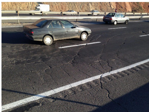
شکل ۱. تصاویری از مشکلات ناشی از خاک متورم شونده در بزرگراه شمالی تبریز
