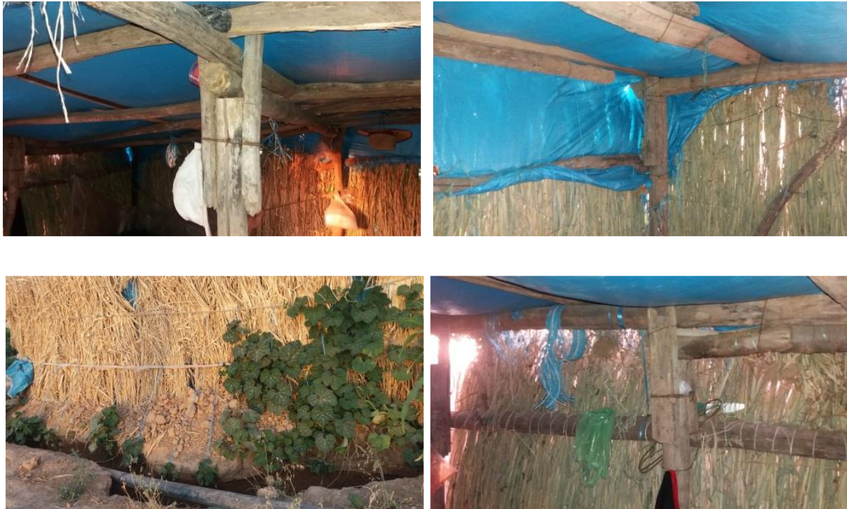
تصاویر ۸ تا ۱۱: نمای داخلی از سازه چوبی و نی‌ها، و نمای خارجی کانال کشی برای رشد گیاه رونده Fig. 8-9-10-11: Inner view of wood and reed structure of Kula; and outer view of them with water canals for growing creeping plants
