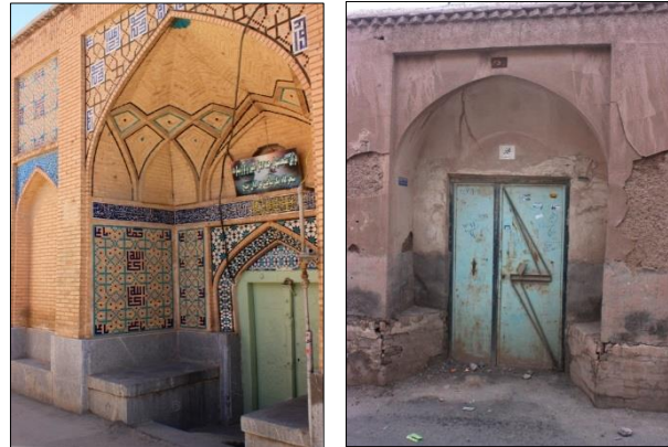
تصویر ۴: سکو، پیش‌طاق، قاب‌بندی، و ... در ورودی خانه و یک مسجد محلی در کرمان (عکس: حجت گلچین) Fig. 5: Components of a house and local mosque entry in Kerman (Hojjat.Golchin)
