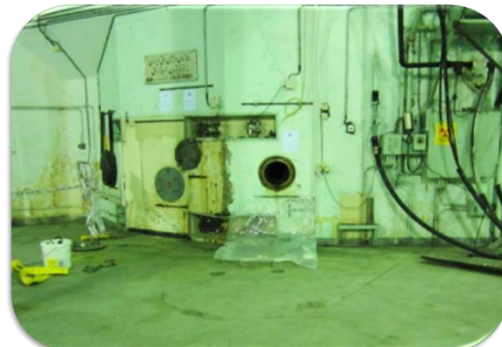
شکل ۴- نمائی از راکتور تحقیقاتی تهران، بیم تیوب‌های آن و بیم تیوب مورد استفاده E در این تحقیق به همراه نمائی از کالیماطور نوترونی طراحی شده
