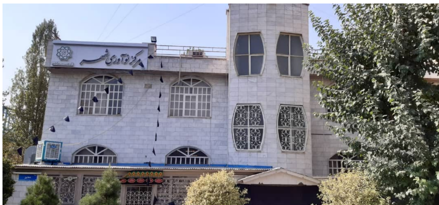
شکل ۱. نمایی از ساختمان اصلی مرکز نوآوری شهرداری تهران
