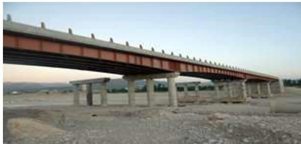
شکل ۳- تخریب پایه‌های پل بشار در اثر برداشت بی‌رویه‌ی شن و ماسه
