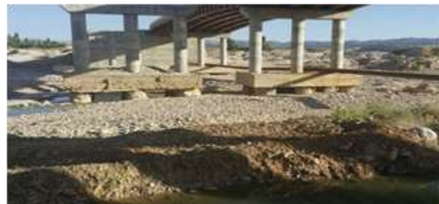
شکل ۳- تخریب پایه‌های پل بشار در اثر برداشت بی‌رویه‌ی شن و ماسه
