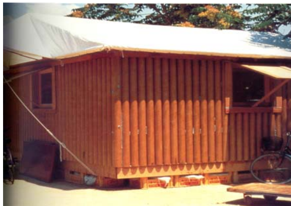
"ت ۱۲" پلان و مقطع سرپناه موقت، فضای درون و بیرون خانه کاغذی در پارک مینامی کوما ناگاتا، کوبه.
