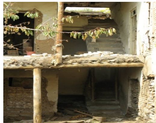
"ت ۱۱ الی ۱۴" جزئیات اتصال ستون به سقف در مدرسه قدیمی سنگان.
