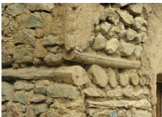
ت ۶" نمایی از جزئیات اجرایی دیوار ساختمان قدیمی.
