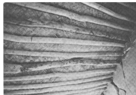
ت ۳. منظره داخلی از سقف تیر چوبی یک خانه در شهر قدیمی قیر. منبع: لی و رازانی، ۱۹۷۳: ۳۰
