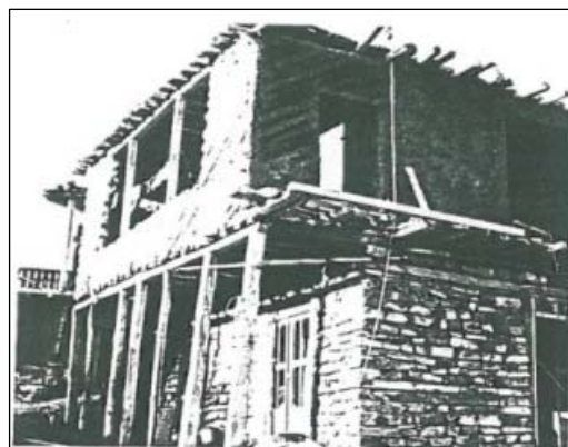
ت ۶. نمونه‌ای مشابه خانه روستای قدیم اسطخ‌کوه که طبقه اول از سنگ و طبقه دوم زیگالی است. (زرگر، میری، آقایی، ۱۳۶۹)
