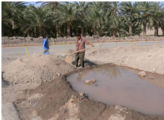
ت ۱. مخلوط کردن مصالح و آخوره کردن.
