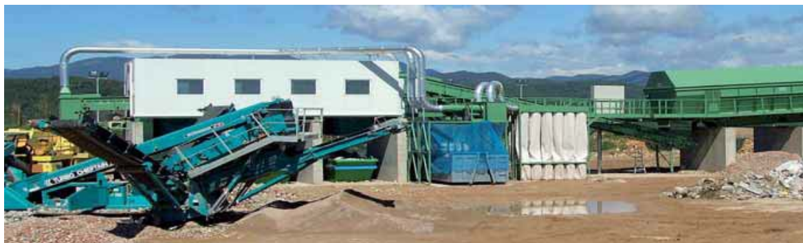
ت ۲. کارخانه بازیافت بتن.
