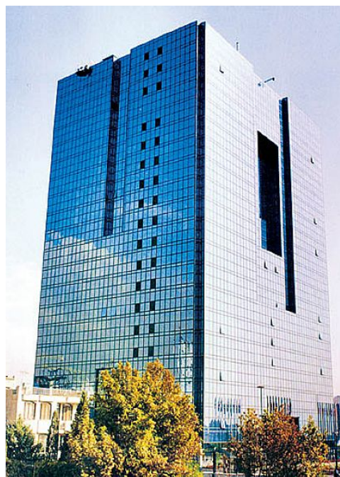
ت ۶. ساختمان بانک مرکزی، تهران.
